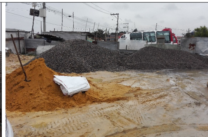
Fotografía No 2. Patio de almacenamiento y empaque
